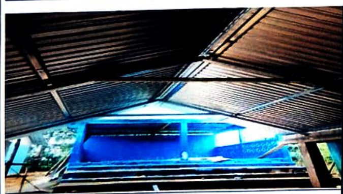
Foto 5: cambio de techo
