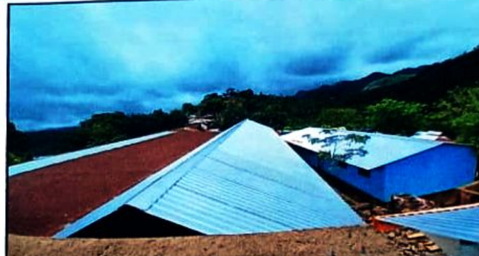
Foto 2: colocacion de laminas troqueladas
