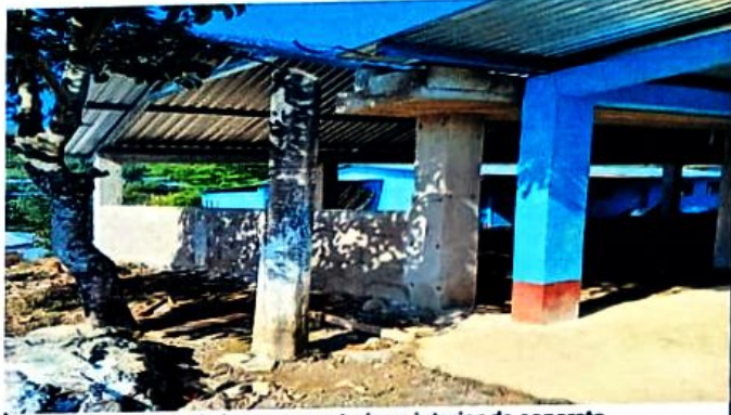
Foto 4: colocacion de horcones exterior y interior de concreto
