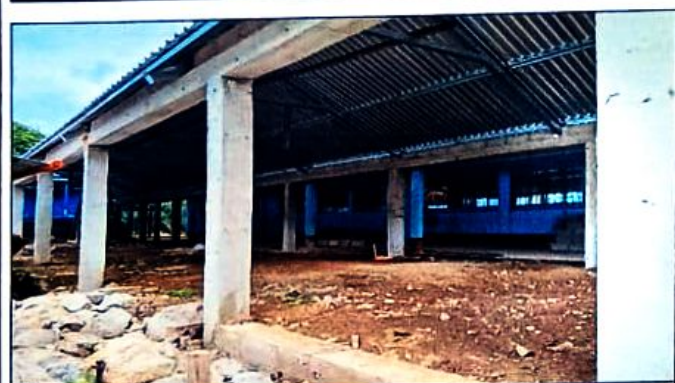
Foto 3: colocacion de horcones
