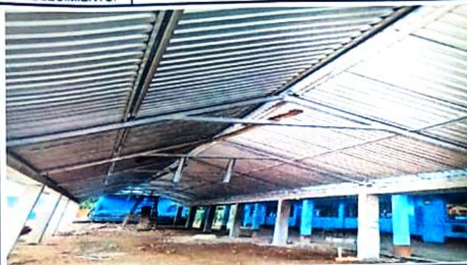
Foto1: colocacion de costaneras
